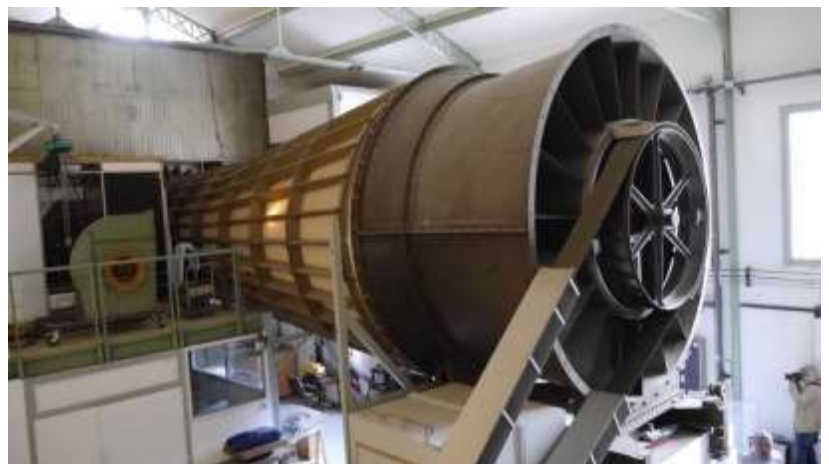
Ventilateur d'aspiration de la soufflerie
