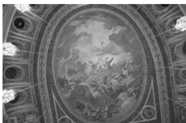
Le plafond, en toile, devait absorber les sons. Peint par Durameau, il a une forme ovale afin d'éviter des angles qui créeraient des tensions sur la toile, et favoriseraient l'effet de "peau de tambour". Il est monté sur un châssis en bois, toujours dans le but d'absorber les sons.
