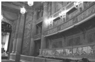
Pour des raisons d'acoustique les deux côtés avant de la scène et la fosse d'orchestre sont cloisonnées, de chaque côté, par 2 très grosses colonnes. Elles sont creuses et fabriquées en peuplier, ce qui permet d'absorber et de renvoyer les sons dans la salle. D'autres colonnes creuses, plus réduites sont placées autour de la salle pour les mêmes raisons d'acoustique et servent en même temps à la décoration. L'orchestre était composé de 80 musiciens.
