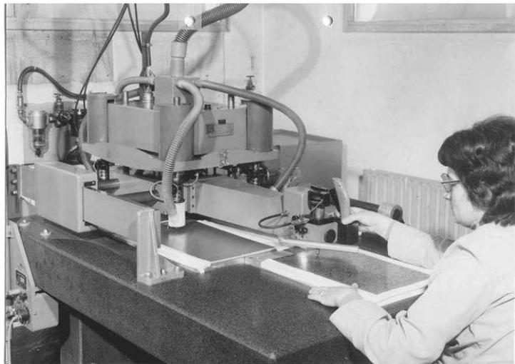
Le perçage des formats se fait sur une machine "Quad drill 1218 Excellon" (livrée en mars 71) qui, comme son nom l'indique, possède 4 têtes sous lesquelles on met trois formats. A chaque déclenchement, l'opératrice perce donc 12 formats simultanément. C'est la taille du lot minimum.
