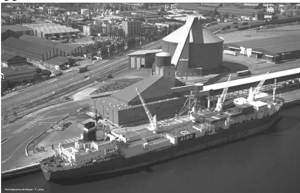
Hangars capables de stocker le temps du transit les 480 000 tonnes de papier-carton importés de Suède ou de Norvège, terminal sucrier stockant 600 000 tonnes de sucre chargeant les 20 000 tonnes du «Bibo» l'un des rares navires au monde capables de fonctionner en mode «bulk in / bag out», anciens hangars aux bananes, immenses tubes métalliques des éoliennes fabriquées en Espagne, chais à vin qui recevaient les
